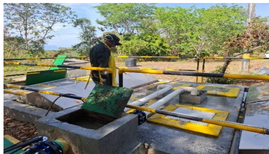
Ilustración N° 124. Mantenimiento red de alcantarillado (10/2025)
